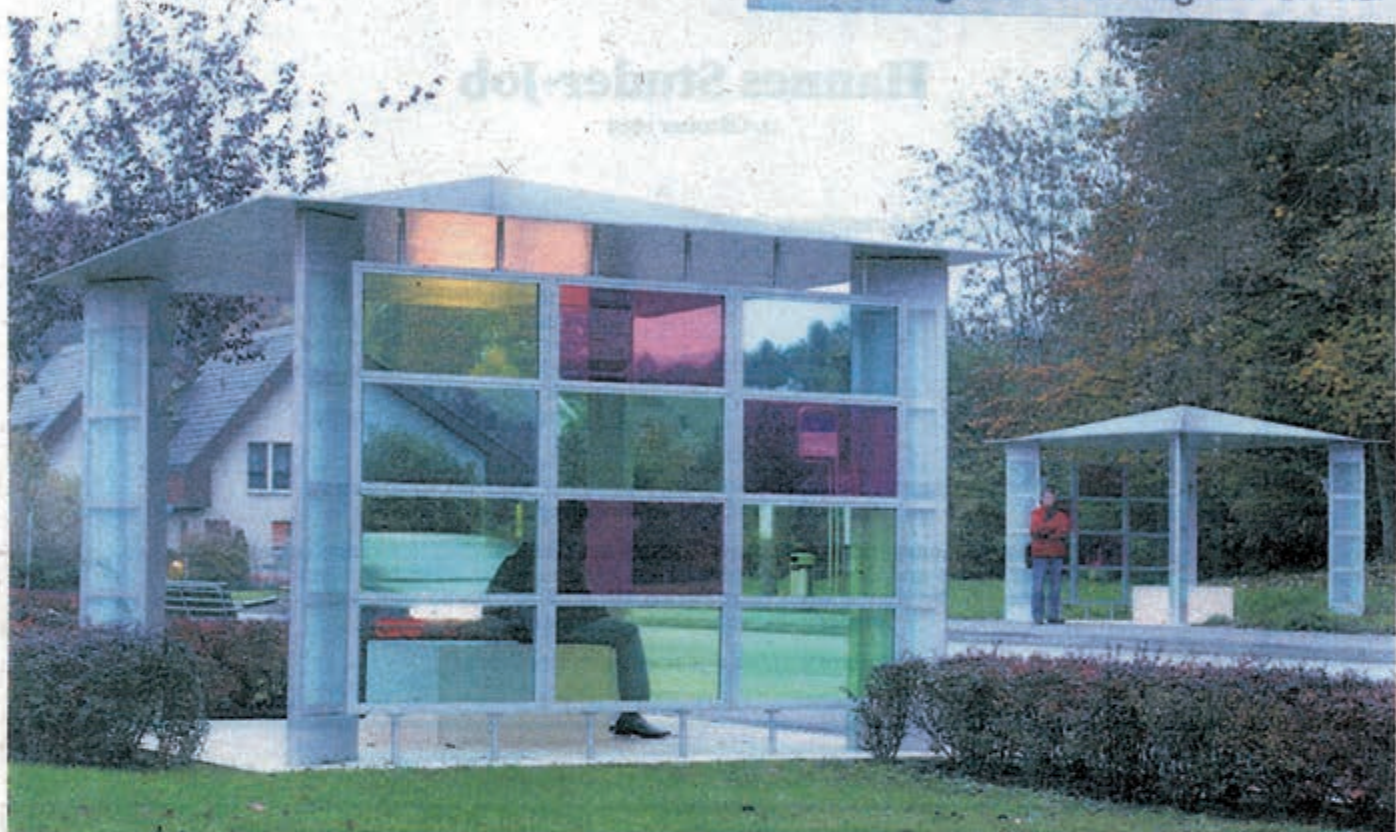
Eine zweite Wand und Holzabdeckungen für die Betonbänke gibts bald auch für die Pavillons an der Eggstrasse. Foto: Patrick Gutenberg
