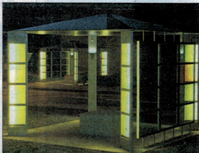
Nachts sollen die Bushäuschen gemäss Architekt Hans Ulrich Imesch eine schmucke Lichtkette in Rüschlikon hinterlassen.
