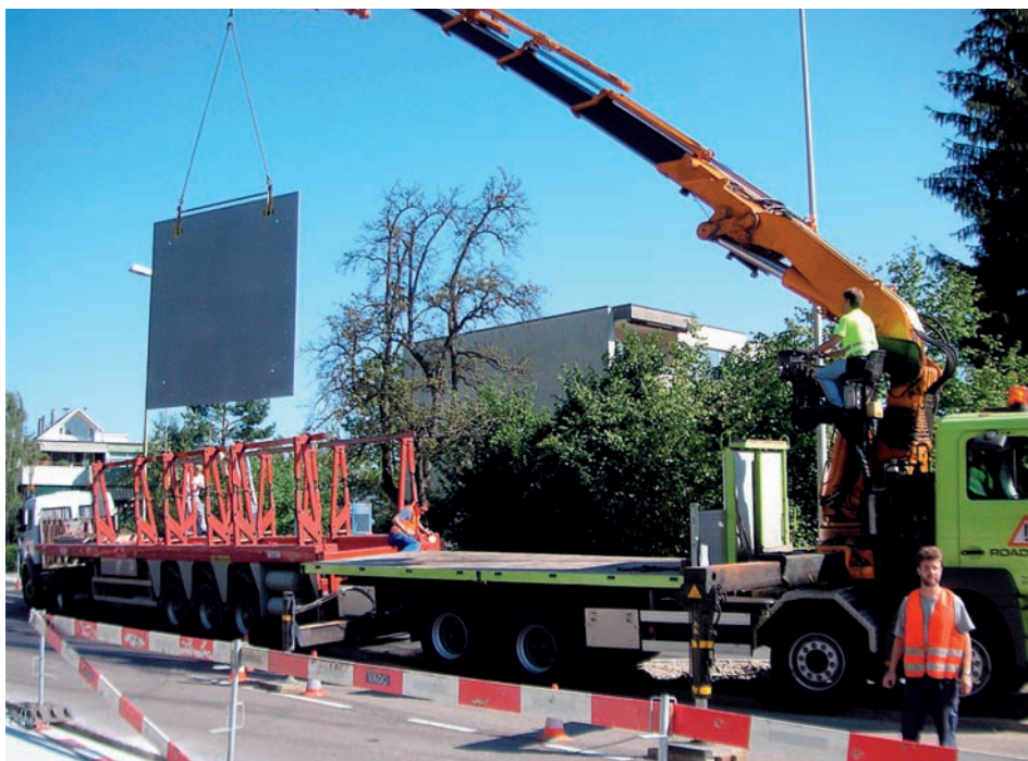
Montage der Dachplatte mit dem PneuKran
